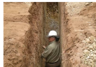
Trench 31 at Sorpresa
